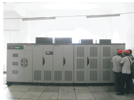
现场安装、调试
